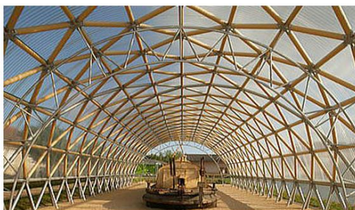
CENTRE D'INTERPRETATION DU CANAL DE BOURGOGNE - Pouilly-en-Auxois, France, 2005
